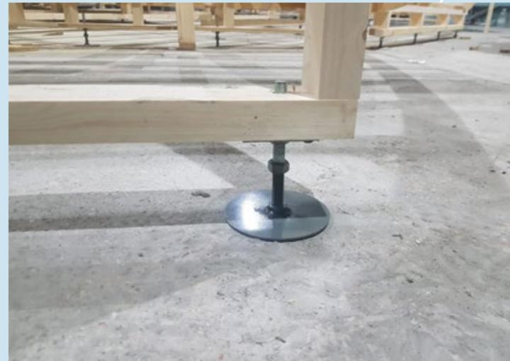
Регулируемые по высоте опоры позволяют производить
