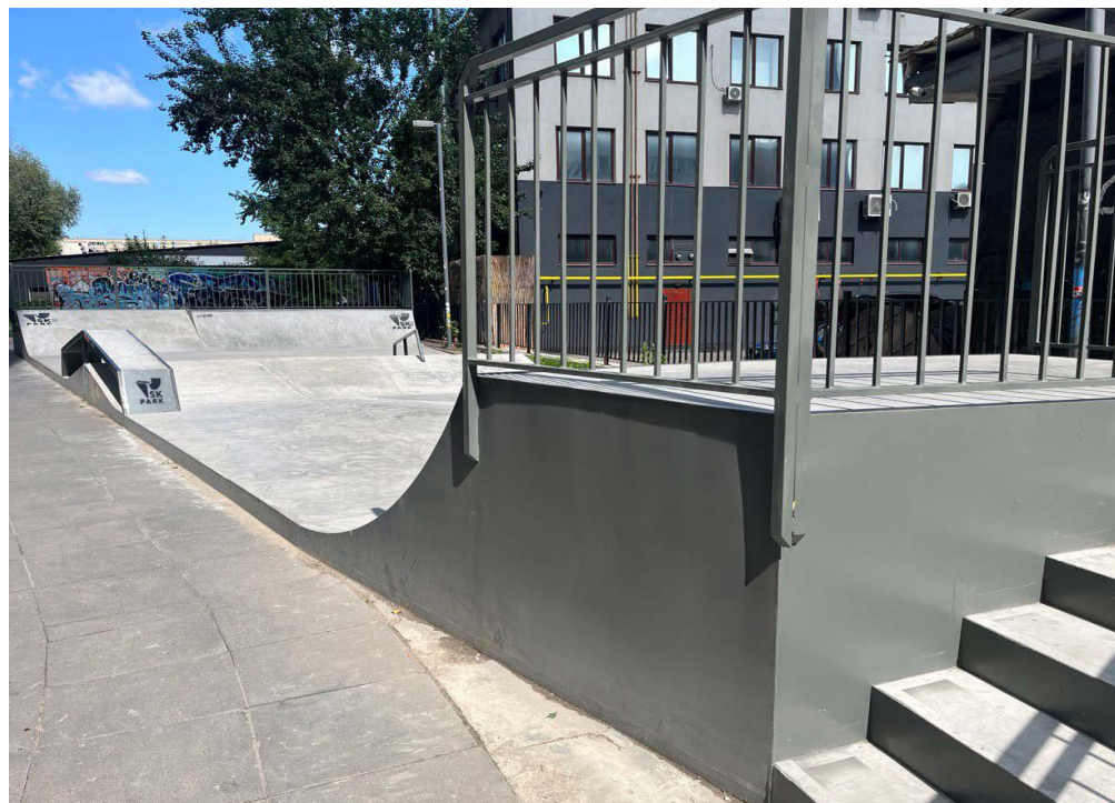
Бетонный скейт-парк, выполненный на несъемной металлической опалубке, Москва
