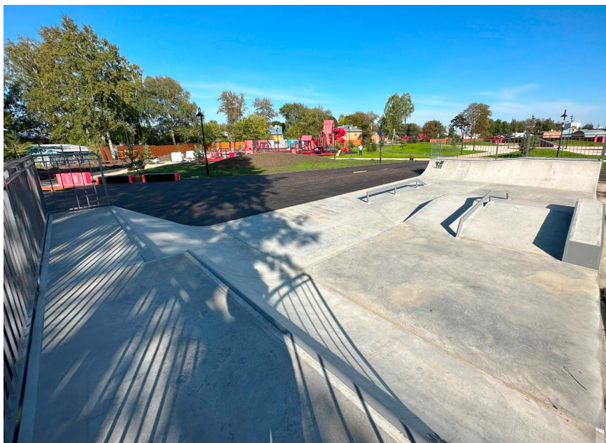
Бетонная скейт-плаза в Киреевске, площадь – 200 кв. м
