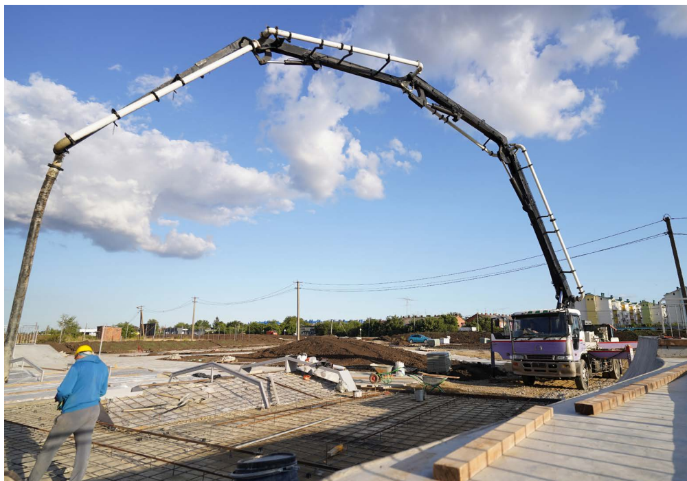
Заливка бетона с помощью автобетононасоса
