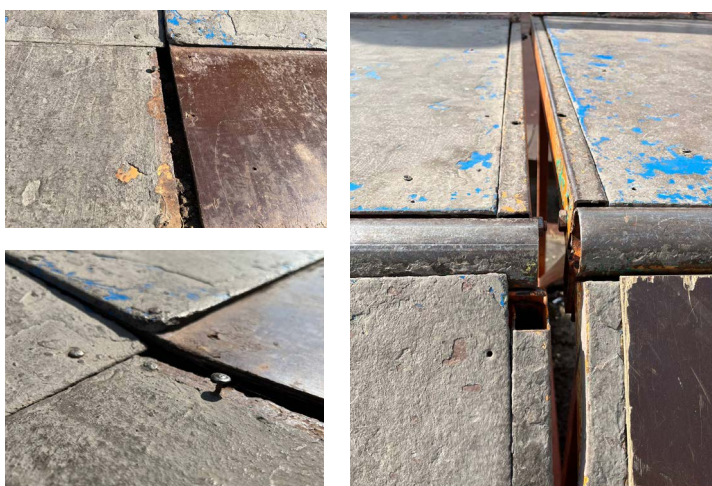
Пример некачественного выполнения фигуры каркасного скейт-парка
