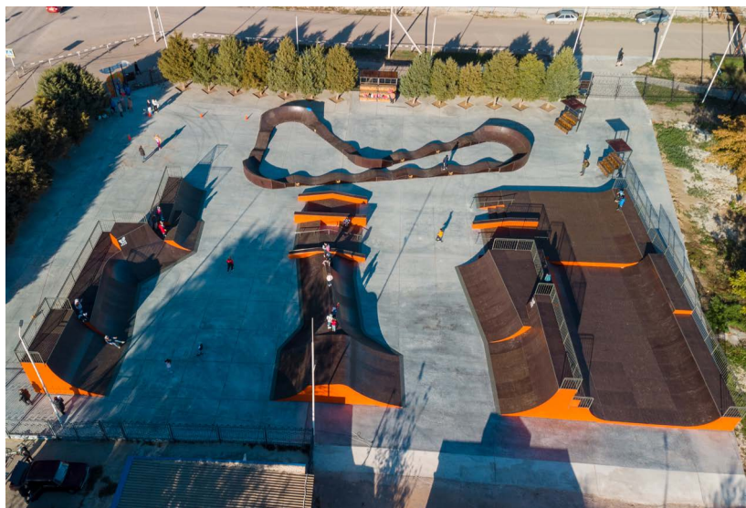
Каркасный скейт-парк в Светлом Яре, площадь застройки – 3000 кв. м
