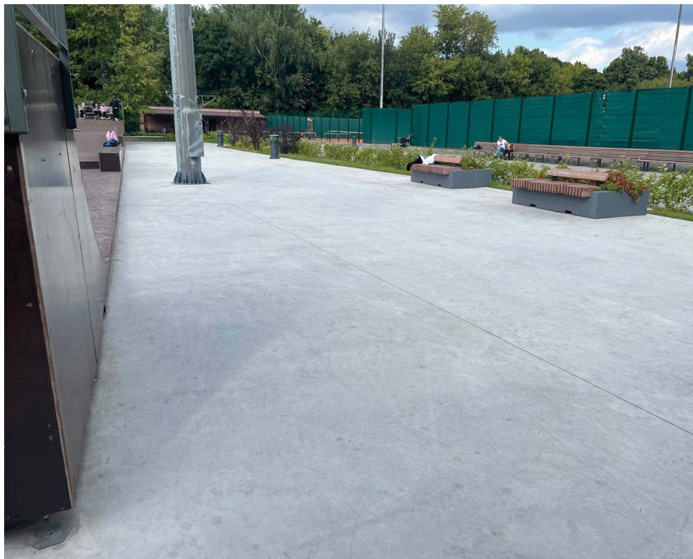
Пример бетонной площадки под каркасный скейт-парк
