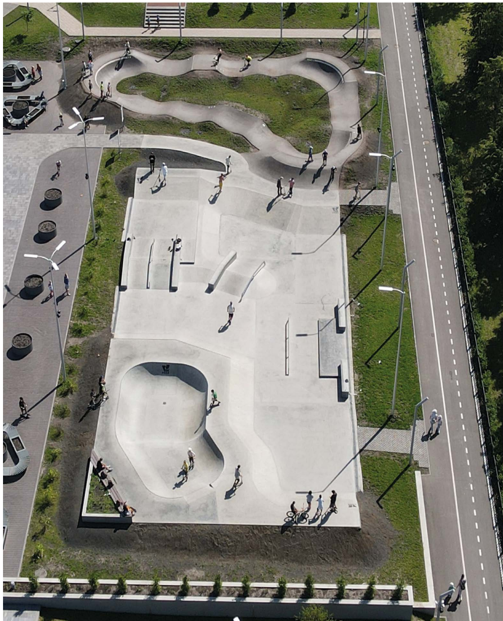
Бетонный скейт-парк с памп-треком в с. Ильинка в Новокузнецком районе, площадь – 1000 кв. м. Построен как объект общественного пространства, подходит для катания в направлении «стрит» и в боуле для райдеров всех дисциплин уровня «начинающий/средний»
