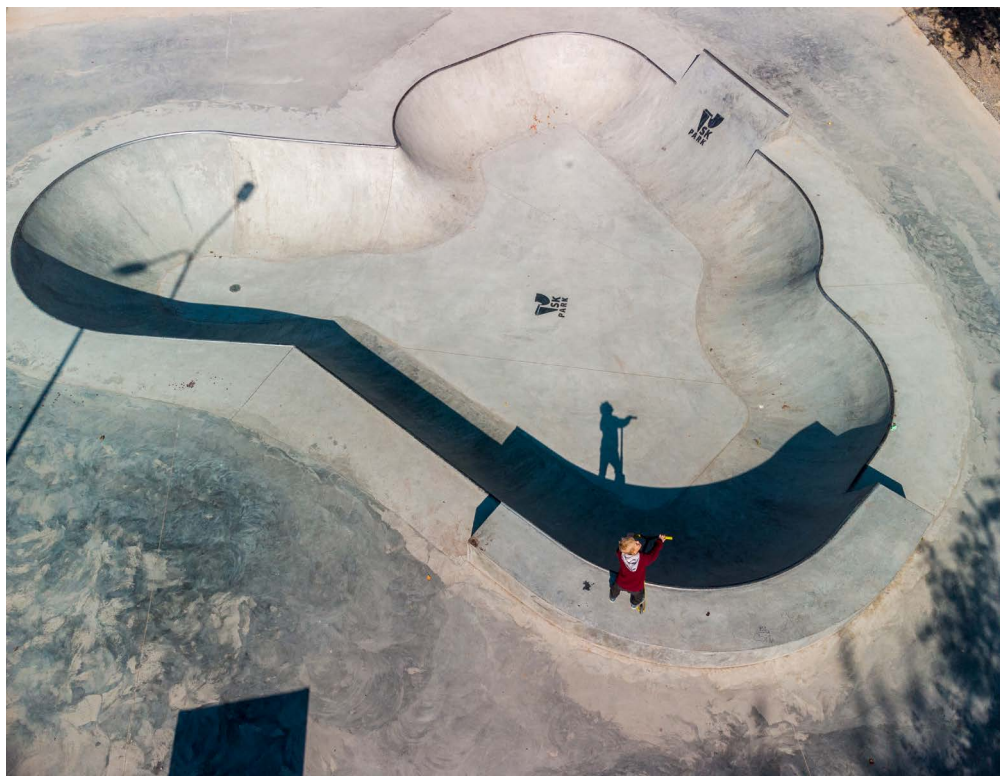
Бетонный боул в Волжском, площадь – 185 кв. м
