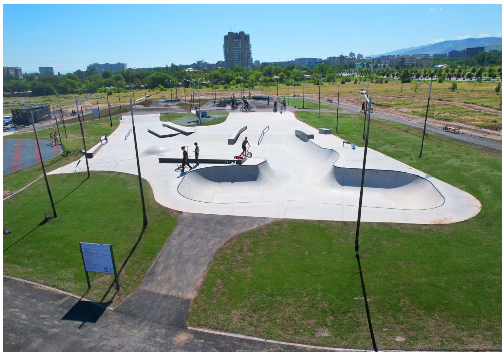
Бетонный скейт-парк в Бишкеке, выполненный на земляных откосах
