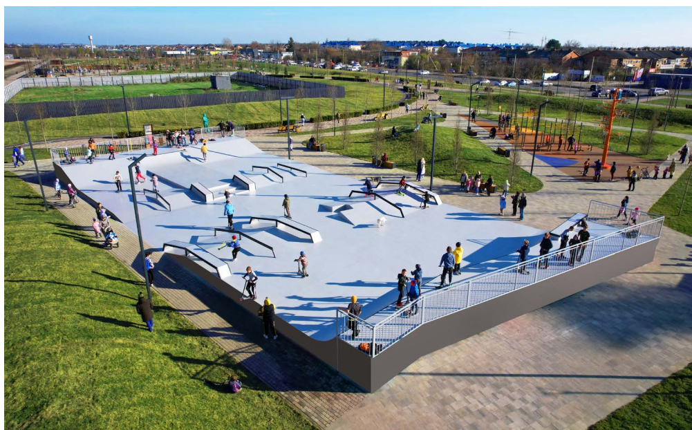
Бетонная скейт-плаза в парке «Родные просторы», Краснодар, площадь – 700 кв. м
