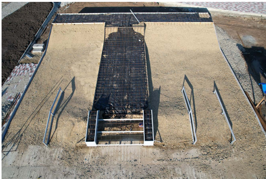
Строительство бетонного скейт-парка на этапе готовности к частичной заливке
